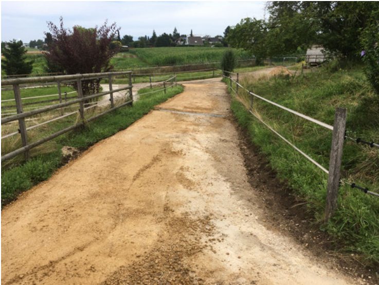
Der Weg zur Gehbahn und der Boden im Offenstallbereich mussten nach einem Unwetter im Juni saniert werden.
